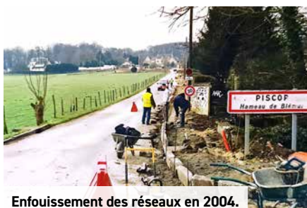
Enfouissement des réseaux en 2004.
