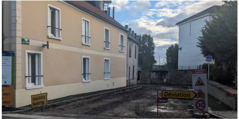
Pendant et après, rue des Petits Poiriers grâce à la rénovation complète réalisée par Plaine Vallée.
